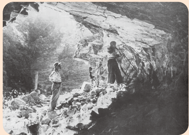
↑民國56年台8線人工開鑿隧道施工情形。
