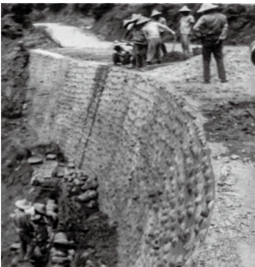
↑民國56年台8線築砌塊石駁坎施工情形。
