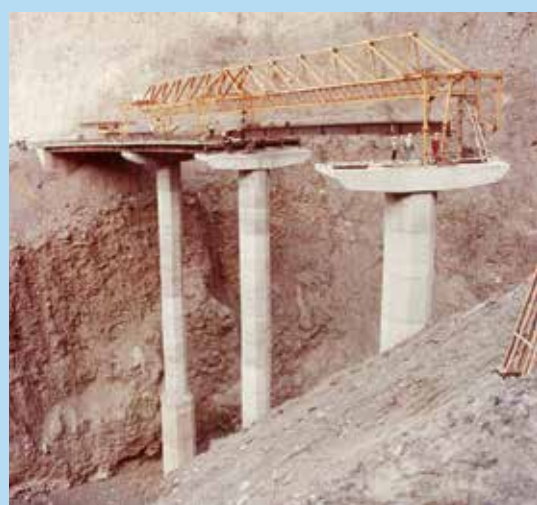
↑民國66年沙烏地夏爾降坡道路工程吊裝鋼樑，施工人員在懸崖山谷間作業，極其驚險。
