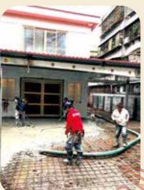
前院地面挖除後，重鋪鋼筋混凝土。 (圖/輔導會)
