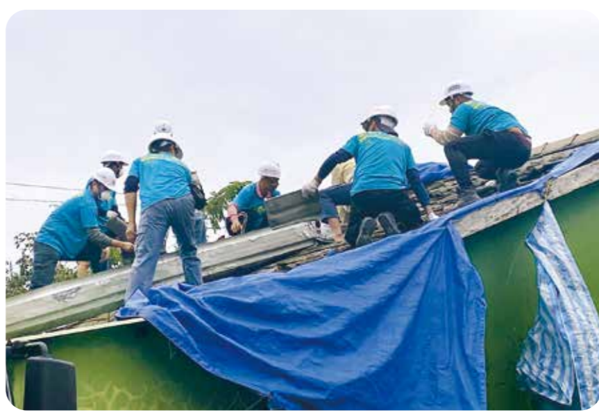
衡山行善團屏東團志工，為遺眷曹阿媽更新鐵皮屋頂，保障她的居住安全。(圖/屏東縣榮服處)
