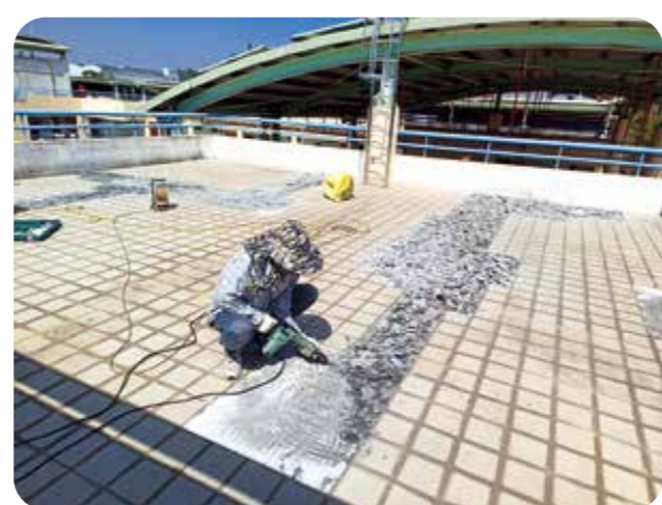
岡山榮家同仁用電動鋸開裂屋頂膨脹龜裂的磁磚及水泥層，重鋪水泥及刷塗防水層，完成修繕。(圖/岡山榮家)
